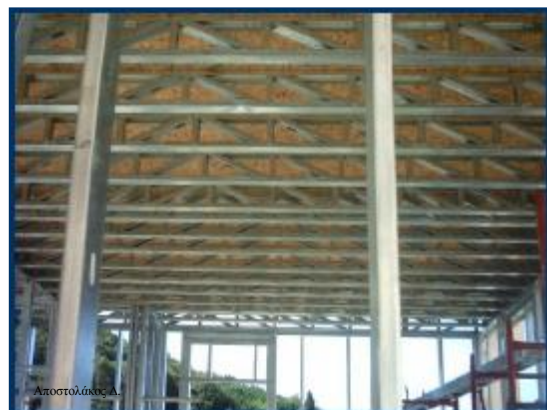
Εικόνα 6: Δικτύωμα πατώματος βίλας στη Λευκάδα
