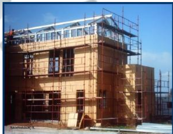
Εικόνα 3: Επικάλυψη με OSB σε βίλα στο Ναύπλιο
