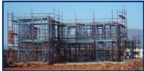
Εικόνα 2: Μεταλλικός σκελετός βίλας στο Ναύπλιο
