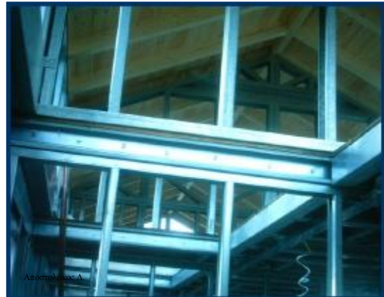
Εικόνα 5: Βατή σοφίτα με ξύλινη σκελή
